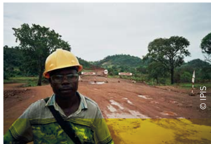
TFM construit d'énormes routes dans la concession.
