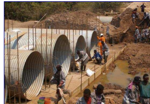
Route et pont de Kasemeno en construction, sept. 2010
