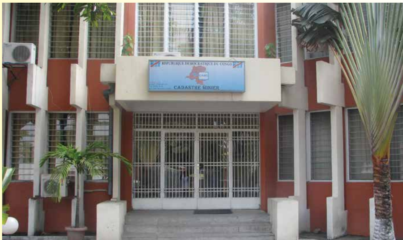
Bâtiment administratif du Cadastre Minier
