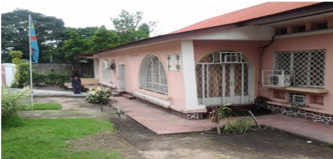
Figure 11 : Bâtiment abritant le Secrétariat Général aux Mines
